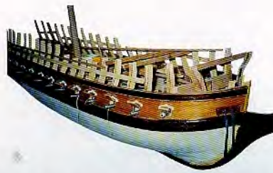
4 – Batería, primera línea, septiembre de 1995, a la derecha escobenes por donde salen los cables del ancla.
