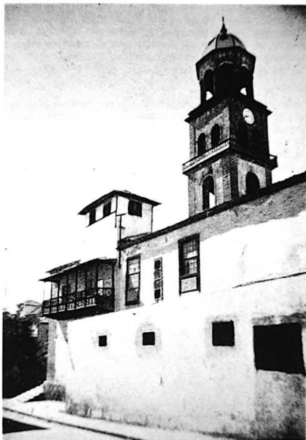
Figura nº 17 Fachada al barranquillo de Guaite, o de los Frailes, del convento franciscano de San Pedro de Alcántara.
