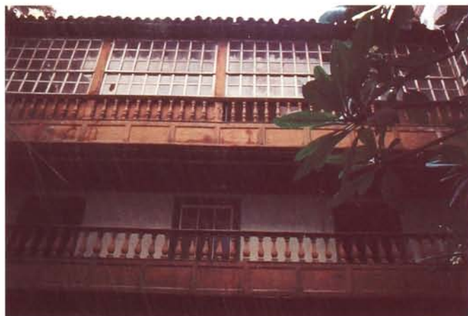
Figura nº 20 Galerías del primer patio de la Casa Forstall. A.D.C.
